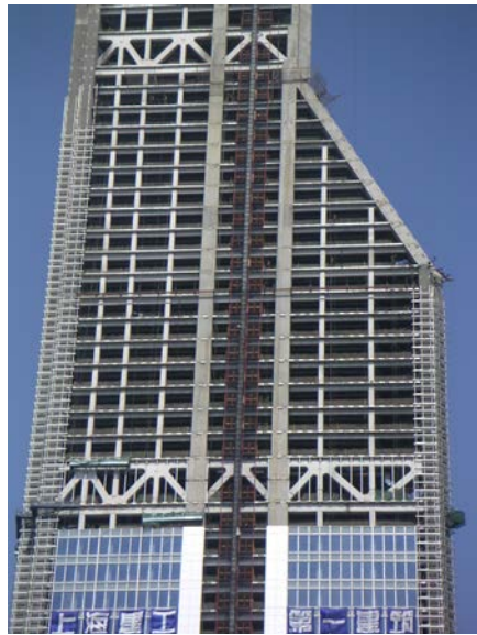
>> โครงสร้างอาคารสมัยใหม่ที่ใช้โครงแบบ Belt Trussed Frame เพื่อเสริมความแข็งแรงให้กับอาคาร
