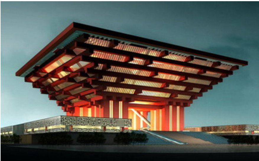
>> ในอาคาร Chinese Pavilion เมืองงาน Expo 2010 ก็ใช้โดว์ก่งที่ถูกทำให้เรียบง่าย (Simplify) มาเป็นแนวคิดในการออกแบบรูปทรงอาคาร
