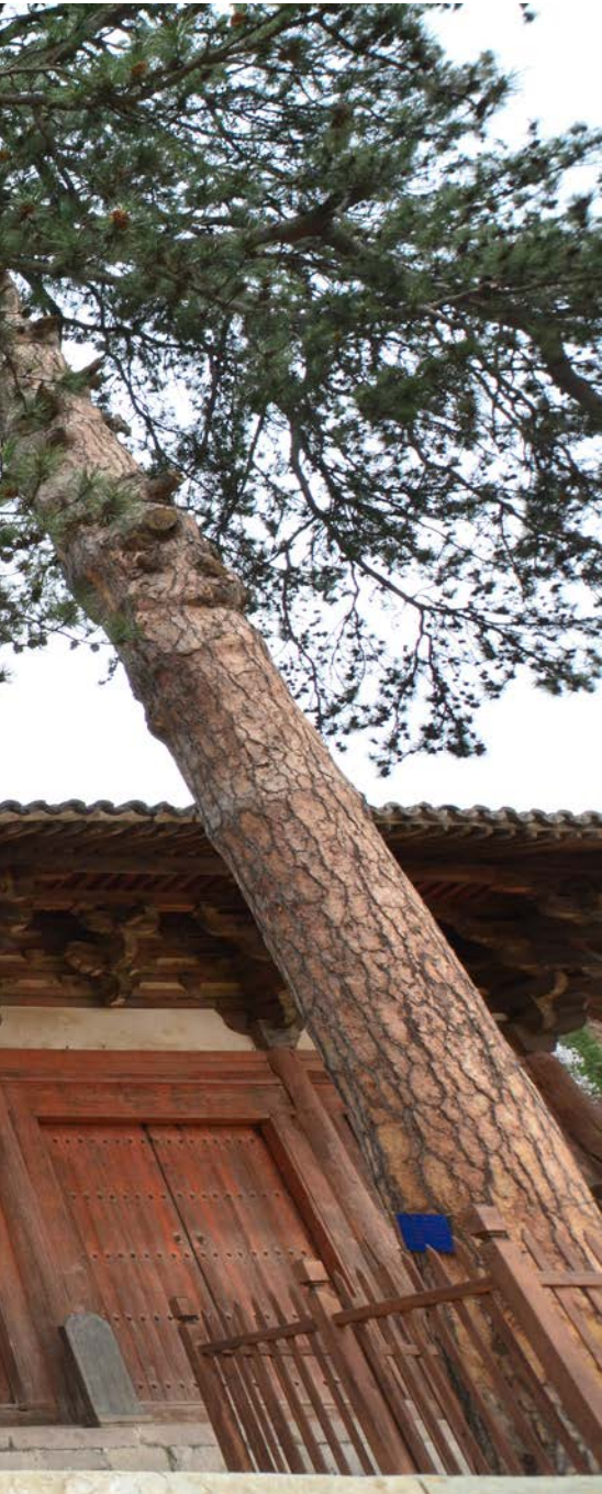
>> ไตว์ก่ง ปุ่มสอดและตัวรับ อันใหญ่โต สมัยราชวงศ์ถัง อายุกว่าหนึ่งพันปี ยังคงดำรงอยู่บน เพดานรองรับหลังคาของพระวิหารตงต้าเตี้ยน วัดฝอกลง
