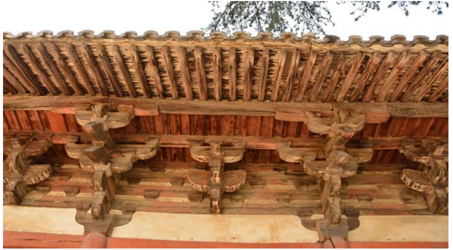
>> ไตว์ก่ง ปุ่มสอดและตัวรับ อันใหญ่โต สมัยราชวงศ์ถัง อายุกว่าหนึ่งพันปี ยังคงดำรงอยู่บน เพดานรองรับหลังคาของพระวิหารตงต้าเตี้ยน วัดฝอกลง
